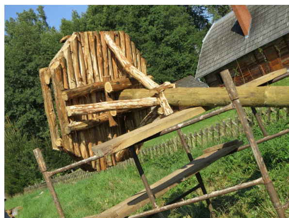
Рисунок 11. Деревянные детали платформы прочно соединены крупными гвоздями.
